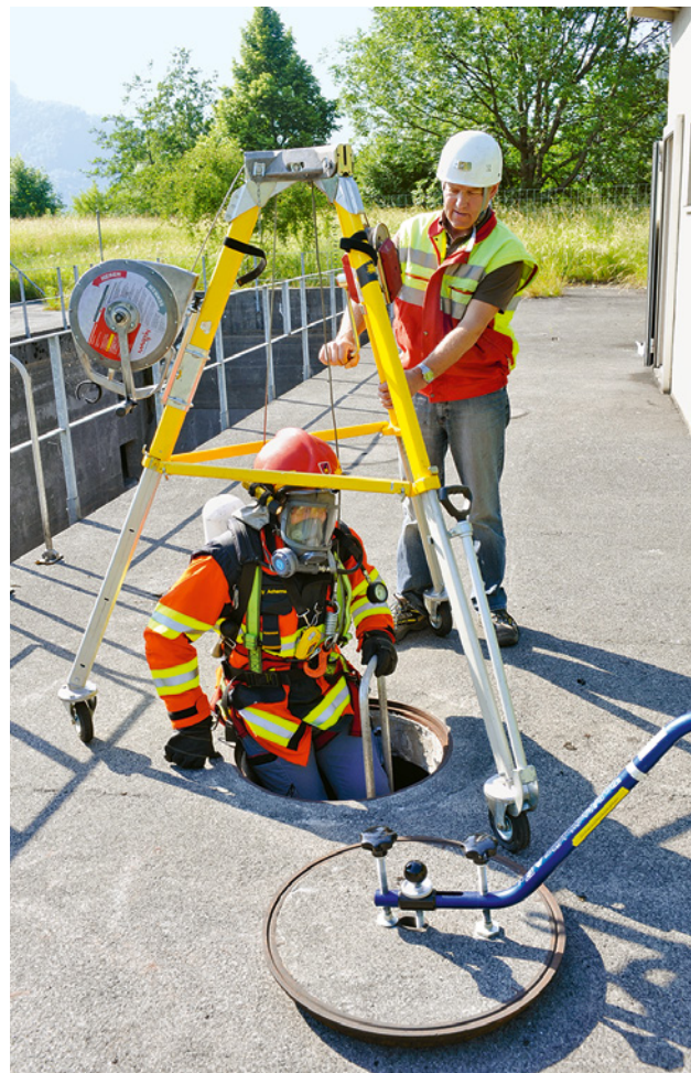
Beim Einstieg in einen Schacht wird die arbeitende Person durch eine zusätzliche Person überwacht.
